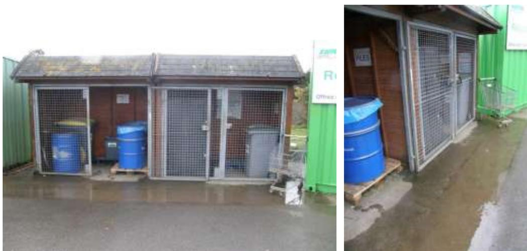
Les huiles minérales sont collectées dans une cuve spécifique, surmontée d'un auvent. La cuve est réhaussée par les poteaux bois, mais ne comprend pas de rétention, qu'il serait nécessaire de prévoir.
